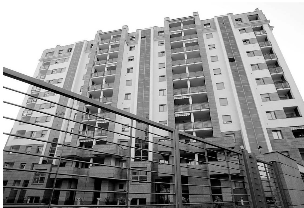
Uno dei complessi su Spina 2, oltre il Palazzo di Giustizia, in un'area dove è prevista anche la nuova Biblioteca unica
