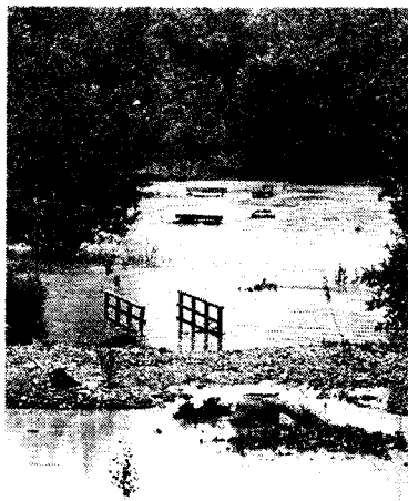
AFECCIONES. La crecida del río ha afectado a zonas inundables durante las últimas semanas. J. C. ARCOS
