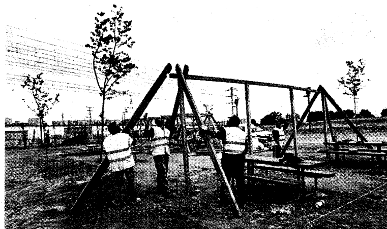
AVANZAN LOS TRABAJOS. En el parque de la desembocadura-habrará mesas de picnic y una pasarela que incluirá un mirador de aves. Se conectará con la ribera del Ebro, en el tramo de Vadorrey. J. C. ARCOS
