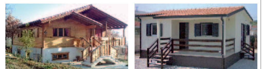
Il legno è antisismico. A sinistra una casa in legno costruita nel 2001 da Rubner Haus nel paese di Sassa, a pochi chilometri dall'Aquila che ha resistito alle scosse di questi giorni; a destra una soluzione di Vpf Srl sempre in legno
