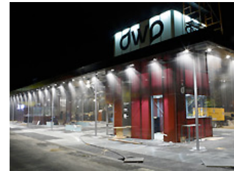
Dispone de más de 3.000 electroválvulas de agua controladas digitalmente
