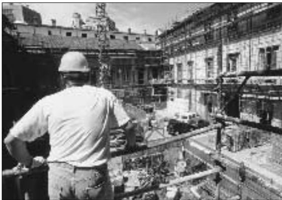
Lavori in corso in un cantiere (Fotogramma)
