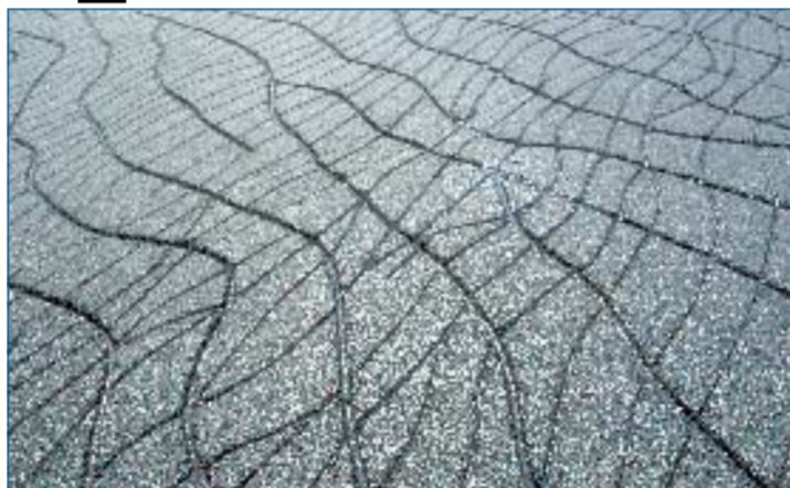
Utrecht, Jaarbeurs Plein, la pavimentazione in asfalto della grande piazza progettata dal gruppo di architetti West 8 costituisce un luogo di interscambio tra i diversi flussi. Sigilla il terreno inquinato della fabbrica che precedentemente occupava l'area. Le incisioni nell'asfalto permettono all'acqua di scorrere senza penetrare nel terreno.
